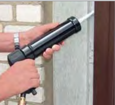
Inyectado – rellenado de ranuras limpio y profesional
