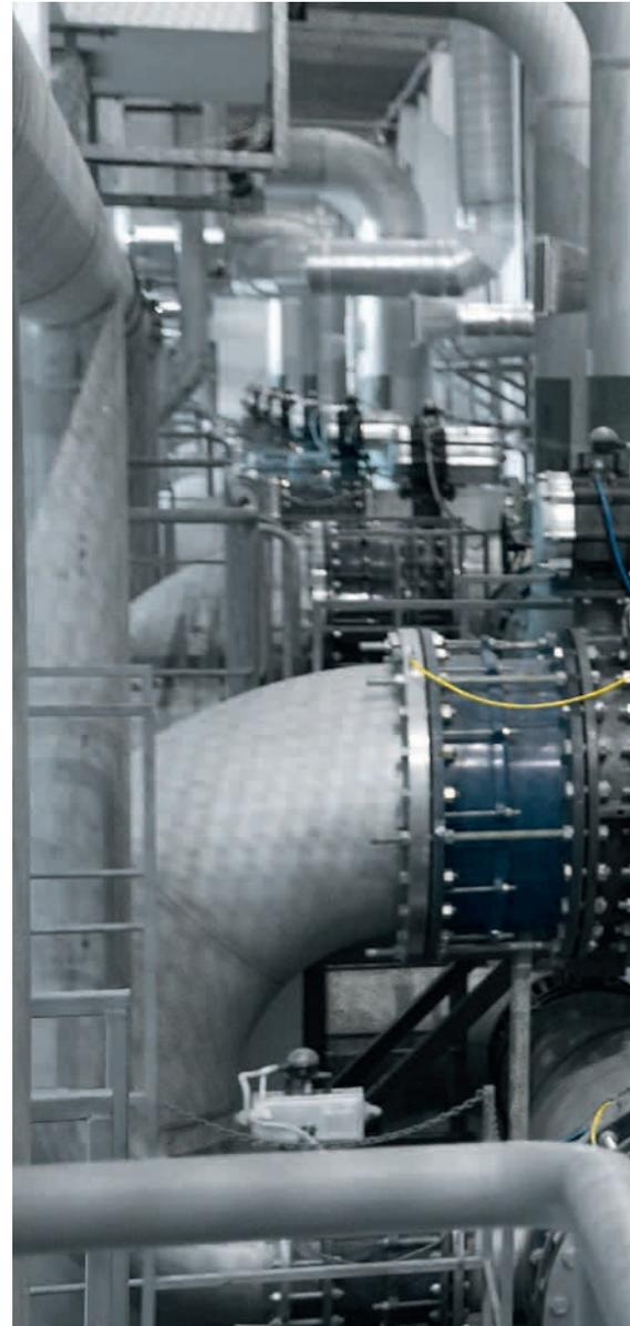
De instalación fácil: las unidades premontadas. 120 actuadores neumáticos DAPS con cajas de señalización de posiciones, para accionar válvulas de cierre en los 20 pozos de filtración.
